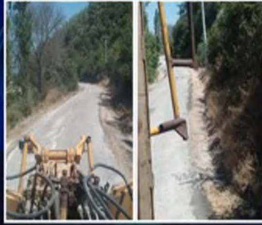
Sarayyanı ve Portakallık Mahalleleri arası Şarmpol açma ve yol temizliği
